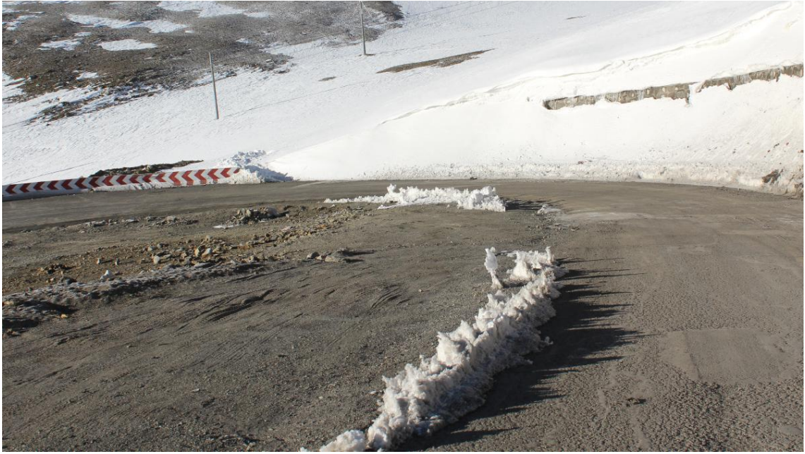
施工生产生活区迹地恢复平整
