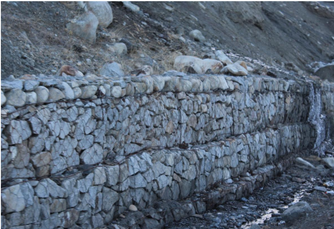
路基工程铅丝石笼拦挡
