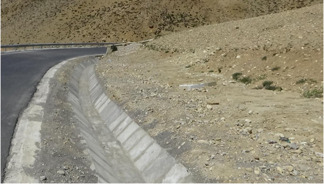
施工生产生活区临时营地
