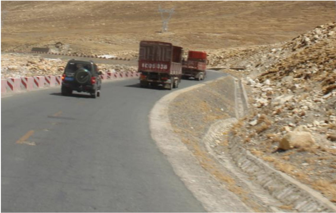
路基工程边坡种草
