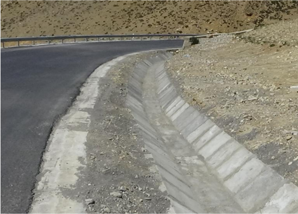
路基工程新修排水沟
